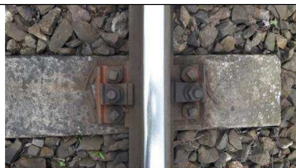
Detail – tuhé podkladnicové upevnění kolejnice na šterkovém loži s betonovými pražci.
