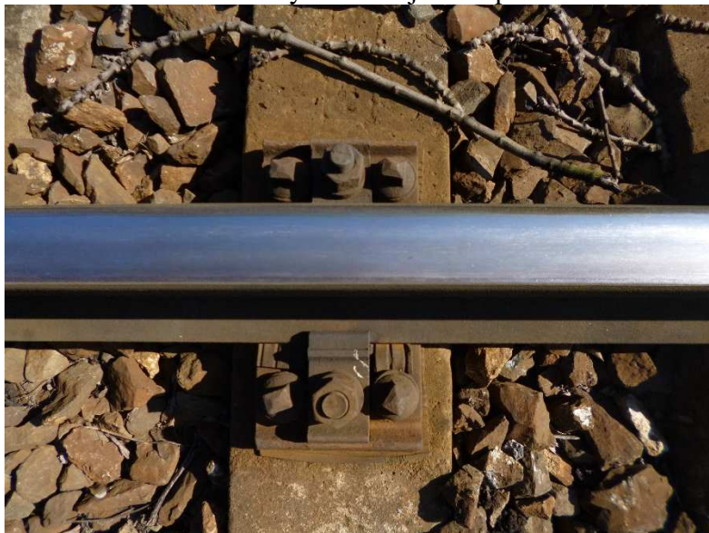
Obrázek č. 12: Pohled na železniční uchycení kolejnice v profilu místa měření M2
